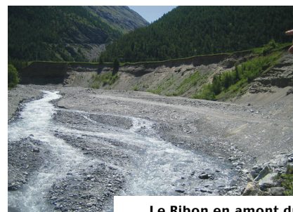
Le Ribon en amont du pont de Charriondaz
