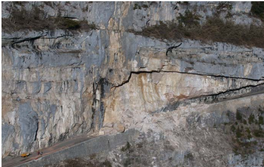
Figure 1. Cicatrice de l'éboulement de la Bourne
