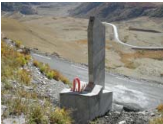
Massif d'ancrage et chemin de câble ne fond de caniveau vers l'abri.
