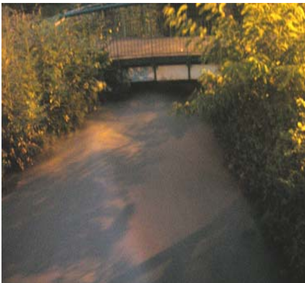
photos 12 : Le Vorz, passerelle du lycée vue de l'amont (a) le 22 août à 20h48 pour un débit proche du maximum de la crue ; (b) le 23 août à 9h18 pour un débit bien moindre. Le tirant d'eau sensiblement identique montre que les dépôts se sont produits à la décrue.
