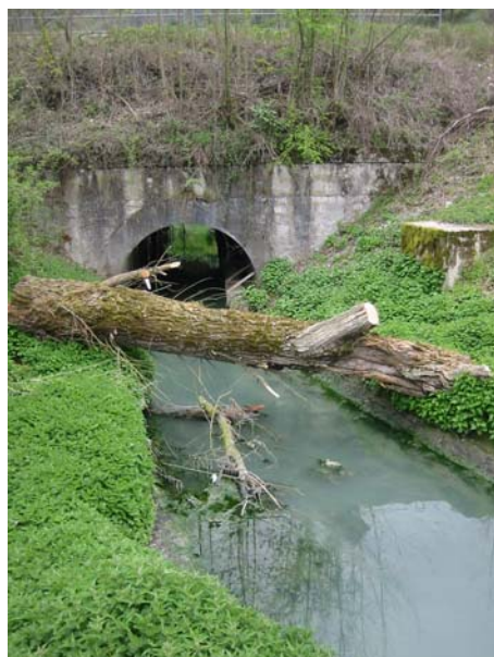
photos 5 et 6 : commune de Villard-Bonnot. L'encombrement de la chantourne au passage de la voie ferrée et du ruisseau de Lancey n'est pas un exemple d'efficacité hydraulique.
