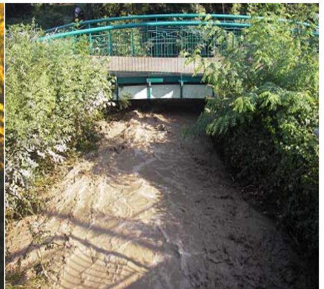
photos 12 : Le Vorz, passerelle du lycée vue de l'amont (a) le 22 août à 20h48 pour un débit proche du maximum de la crue ; (b) le 23 août à 9h18 pour un débit bien moindre. Le tirant d'eau sensiblement identique montre que les dépôts se sont produits à la décrue.
