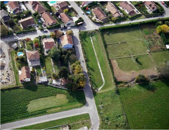
photo 7 : bassin d'infiltration, quartier du Berlioz
