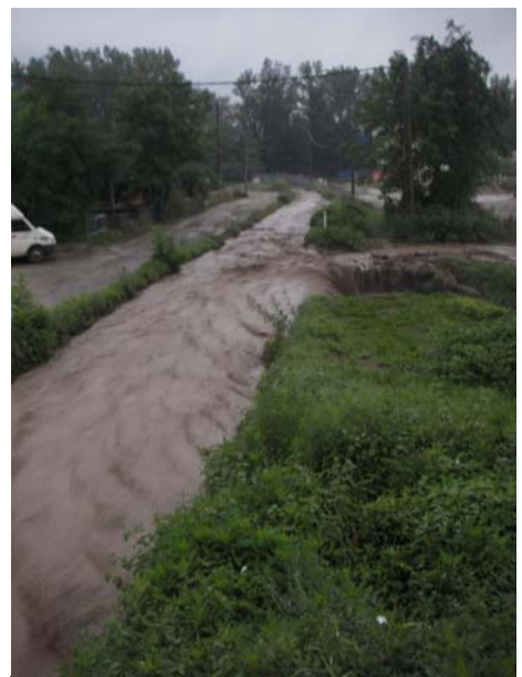
photo 10 : brèche du ruisseau de Lancey, déversement dans la Chantourne (22 août 2005).
