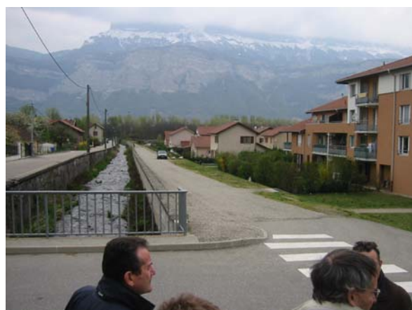
photo 1 : commune de Froges. Urbanisation en contrebas du ruisseau des Adrets. La vulnérabilité de ces constructions récentes semble peu compatible avec la capacité du lit à évacuer les crues du torrent.
