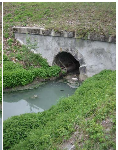
photos 5 et 6 : commune de Villard-Bonnot. L'encombrement de la chantourne au passage de la voie ferrée et du ruisseau de Lancey n'est pas un exemple d'efficacité hydraulique.
