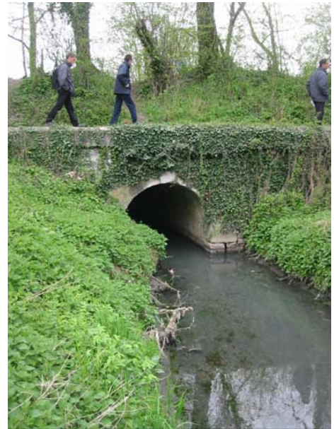
photo 9 : passage souterrain de la Chantourne sous le Vorz
