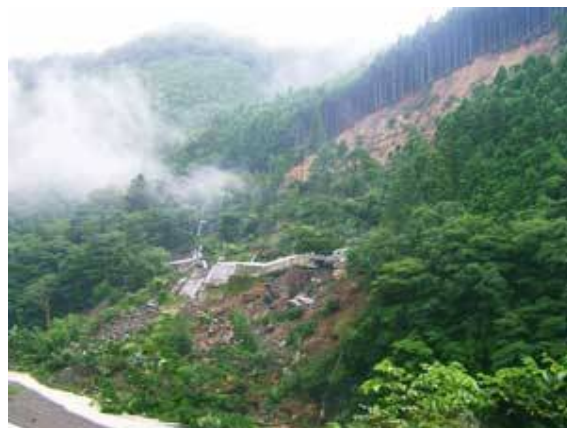
Glissement de terrain à Village Daitô (10/08/2004)
