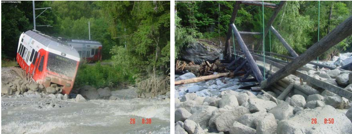
Voies de chemin de fer déplacées sur plusieurs dizaines de mètres et passerelle engravée au lendemain de la crue
