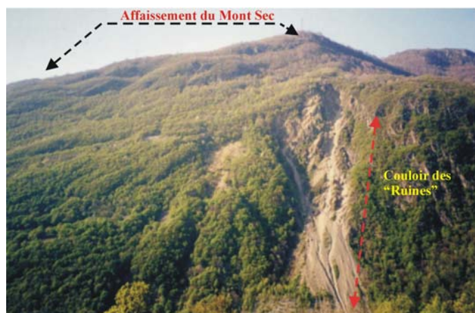
Vue du versant des Ruines de Séchilienne depuis la station de surveillance de Montfalcon
