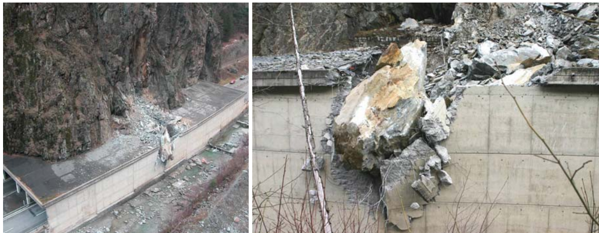
Effet de poinçonnement sur la galerie lors de l'éboulement du 29 nov. 2003
