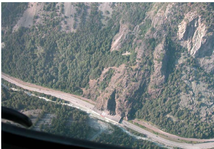
Eperon rocheux du site des Trappistes sur la route du Grand Saint Bernard
