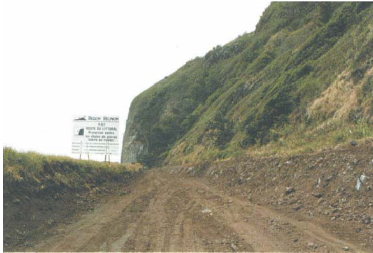
Photo 5.1.7 - Fosse aménagée en pied de falaise sur la RN (Ile de la Réunion).
