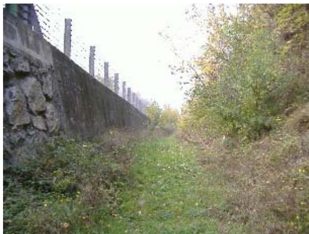
Photo 5.1.8. Fosse de réception située à l'arrière du mur de protection de la RN 26.
