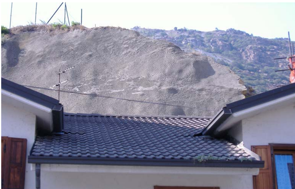
Photo5.10.1 – Paroi rocheuse stabilisée à l'aide de gunite dans le bourg de Châtillon. Cliquez pour agrandir
