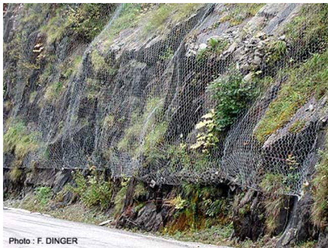
Photo 5.12.1 : Talus revégétalisé et protégé par un grillage. (Cemagref.)
