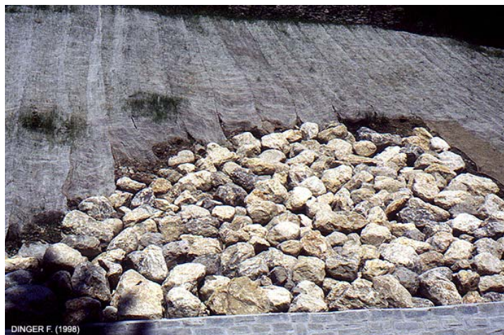
Photo 5.12.3. Massif drainant et géotextile avant revégétalisation (RD 525 à Pinsot). Cemagref.).
