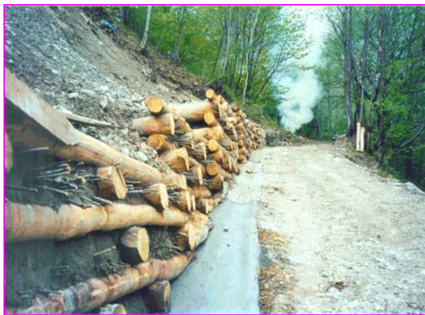
Photo 5.12.4. Vue d'ensemble du caisson forestier construit en pied de versant.
