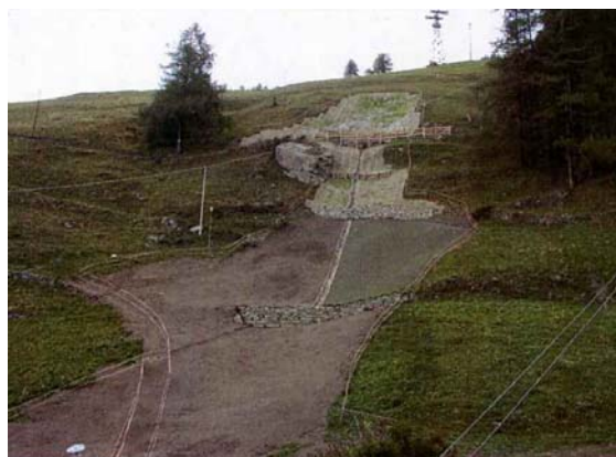
Photo 5.12.6. Glissement de Frantze après les travaux d'aménagement
