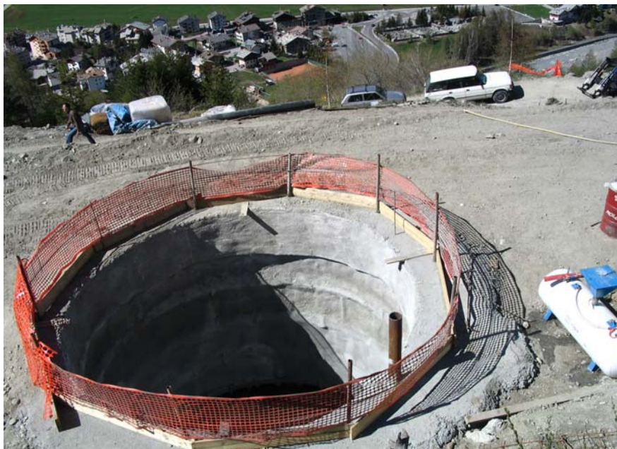
Photo 5.14.2 – Puits drainant en cours de réalisation
