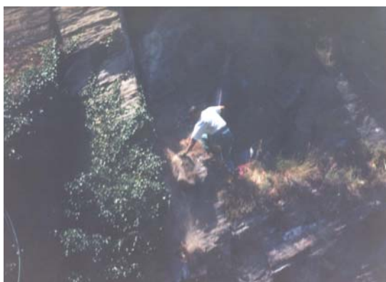
Photo 5.7.2. Purge manuelle d'un bloc instable.
