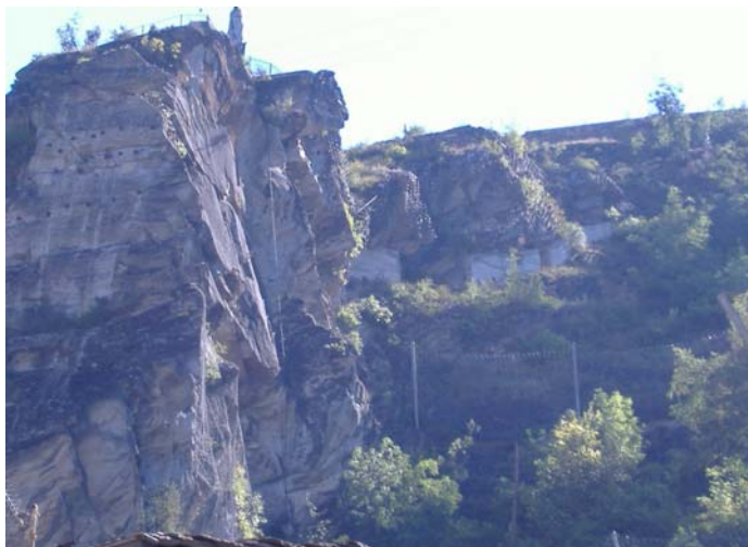
Photo 5.8.1 – Vue d'ensemble de la paroi confortée. On y distingue des ancrages passifs, des filets et grillages plaqués, des butons en béton et une barrière de filets faiblement déformable.
