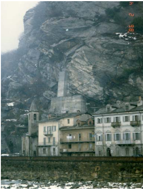
Photo 5.8.4 – Contrefort en béton armé
