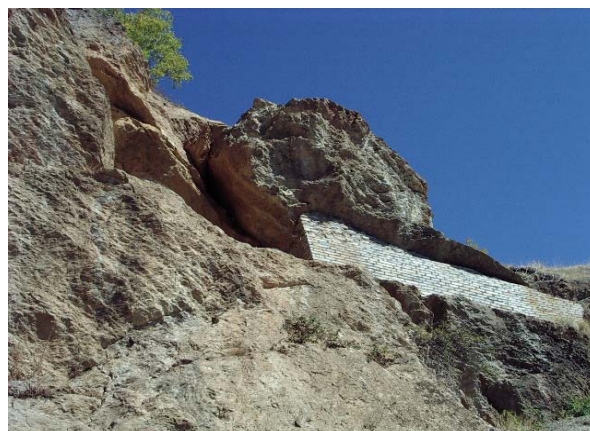
Photo 5.8.3 – Détail du contrefort en maçonnerie.
