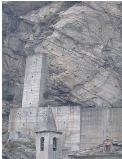
Photo 5.8.5 – Vue d'ensemble de la paroi confortée durant les années '90. A noter les ancrages passifs mis en place sur la paroi et masqués avec des coffres en béton.
