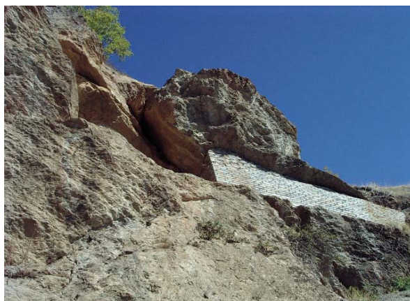
Photo 5.8.3 – Détail du contrefort en maçonnerie.
