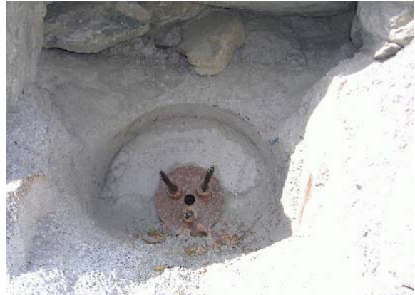
Photo 5.3: Détail du tirant avec les trois torons et la plaque de répartition.
