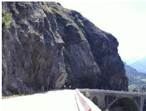
Foto 5. 1: Panoramica della parte con gli ancoraggi passivi (al centro) e le reti addossate.
