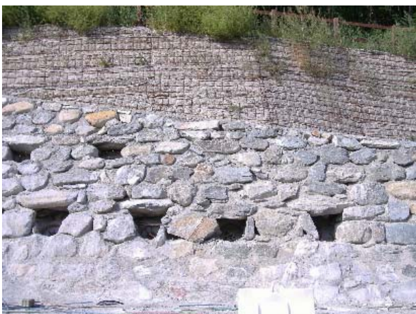
Foto 5.2: panoramica del muro di sostegno e degli ancoraggi attivi (nei fori).
