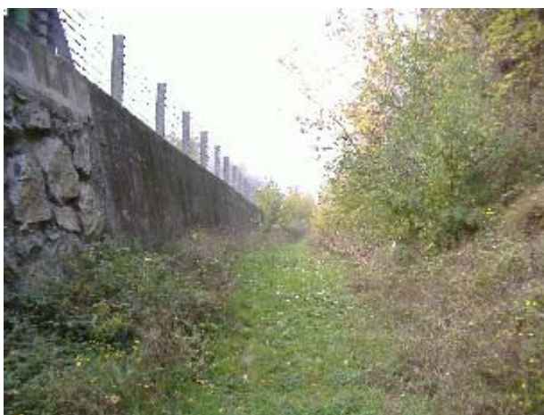
Photo 5.1.8. Fosse de réception située à l'arrière du mur de protection de la RN 26.
