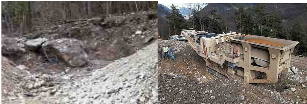
Photos 5.1.3 et 5.1.4 : Pomblières - présence de gros blocs incompatibles avec la technique de renforcement du merlon en couches géotextiles. Le problème a été résolu par le concassage des blocs sur place.
