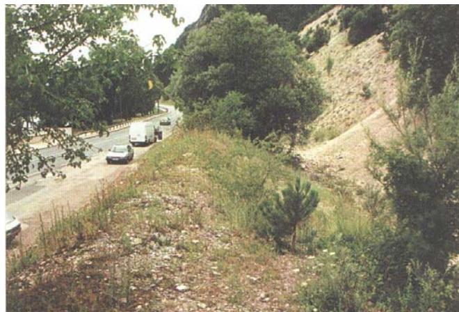
Photo 5.1.5 : Barrage constitué d'une simple levée de terre entre la route et le pied de talus (Cete Lyon).
