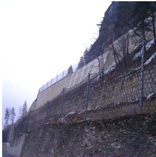
Photo 5.1.6. Vue d'ensemble du merlon en béton armé. A noter en aval du merlon la présence d'un écran déformable en anneaux pour protéger la RR 47 de Cogne.
