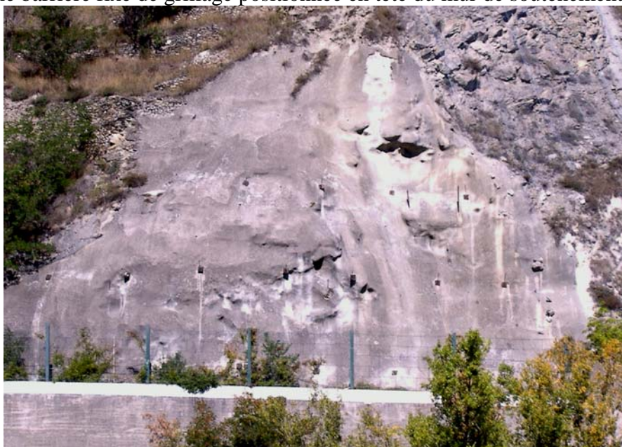
Photo5.10.2 – Talus rocheux stabilisé à l'aide d'une couche de béton projetée sur un treillis d'armature ancré au talus. On observe, au premier plan de la photo, la barrière fixe de grillage. Cliquez pour agrandir
