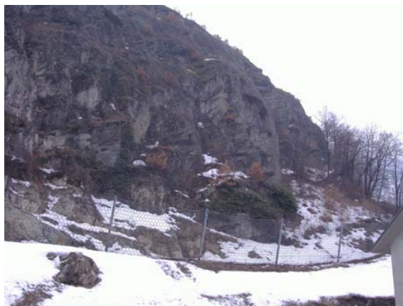
Photo 5.11.4. Combinaison de mesures de protection en amont de la route nationale RN26, au lieu dit Chef-Lieu, commune d'Arvier.
