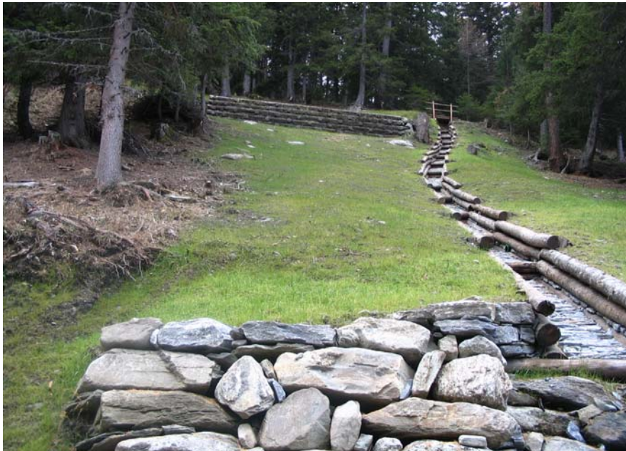
Photo 5.13.3. Aménagement du glissement.
