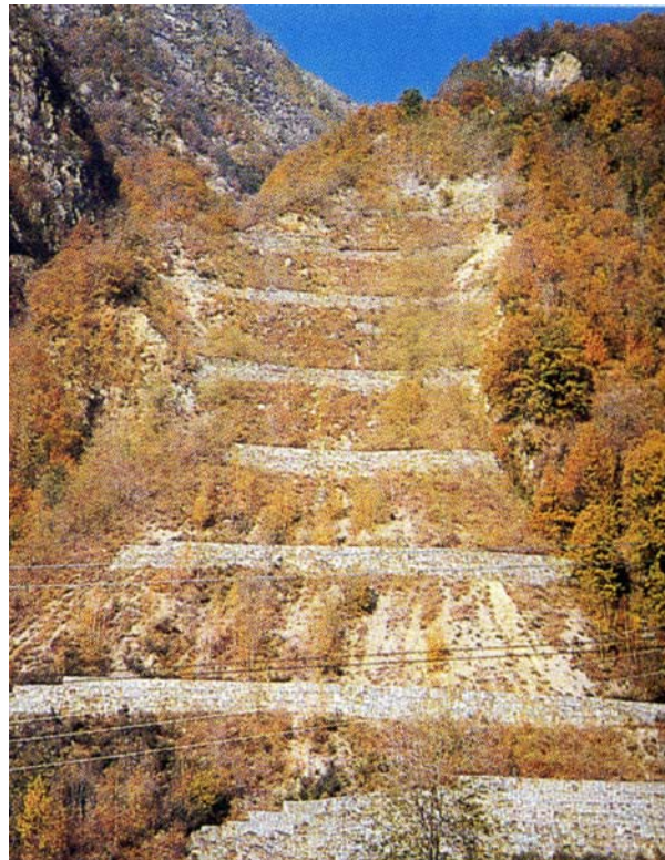
Photo 5.2a.2 – Eboulement de Theilly aménagé à l'aide de terrasses formées avec des écrans de gabions.
