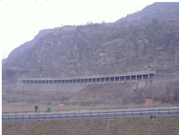
Photo 5.5.4. Galerie de section rectangulaire sur la RN 26 (Km. 108+350), communes de Sarre – Saint-Pierre, vallée d'Aoste Cliquer pour agrandir
