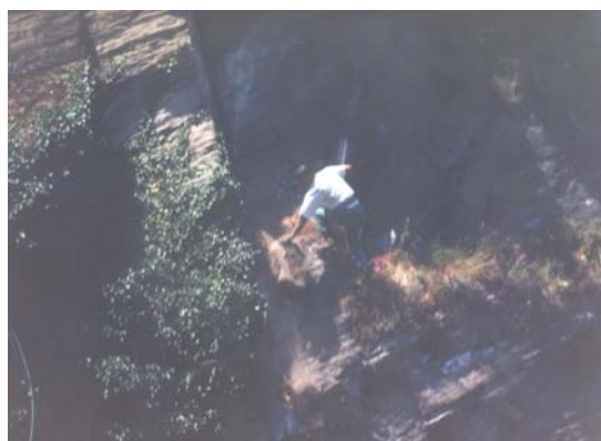
Photo 5.7.2. Purge manuelle d'un bloc instable.
