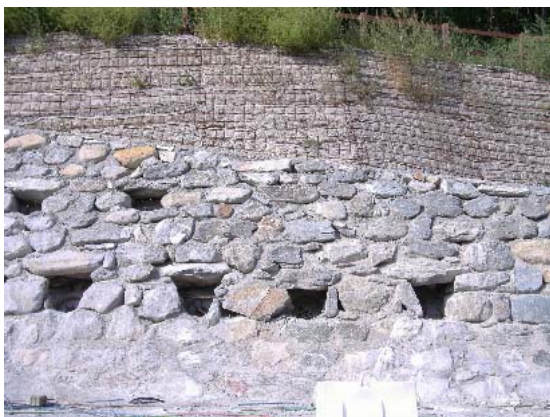
Photo 5.9.2: vue d'ensemble du mur de soutènement et des ancrages actifs (dans les trous). Cliquer pour agrandir
