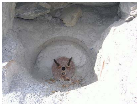
Photo 5.9.3: Détail du tirant avec les trois torons et la plaque de répartition. Cliquer pour agrandir
